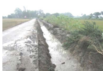
หมู่ที่ ๗ จากคลอง มอ. ถึง นา นายบน อุ่อรุณ (พร้อมขนย้ายดิน) ระยะทางยาว ๑,๐๐๐ เมตร
