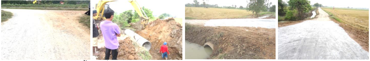
๗. โครงการฝังท่อระบายน้ำ หมู่ที่ ๒
