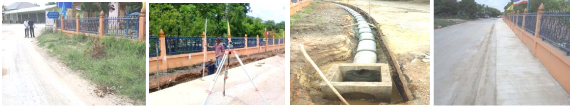
๘. โครงการก่อสร้างถนนดิน (ขยาย) หมู่ที่ ๓ ตำบลบ้านสระ
