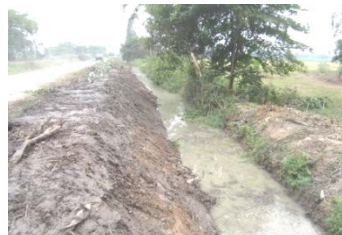
หมู่ที่ ๗ จากคลอง มอ. ถึง หมู่ ๑๐ เลียบคลอง ๑๑ ระยะทางยาว ๑,๙๕๐ เมตร
